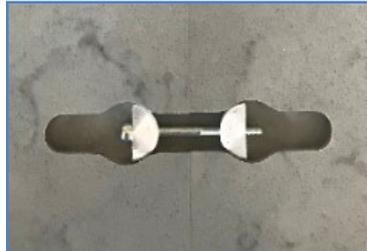
Abbildung 10: Arbeitsplattenverbinder
