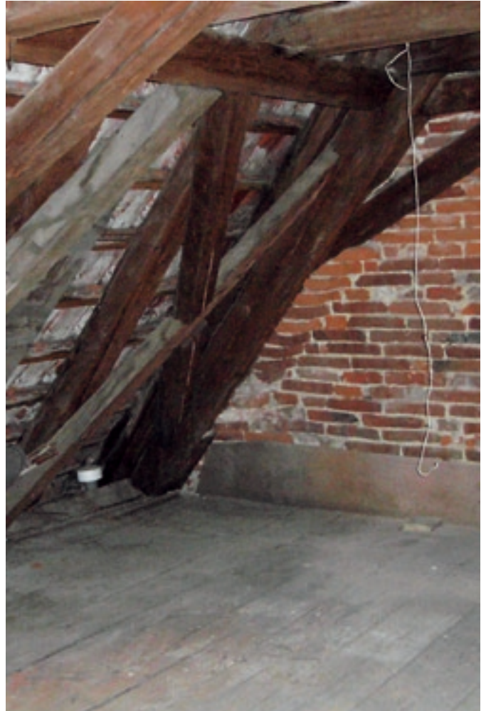
DACHSTUHL IM UNSANIERTEN ZUSTAND
